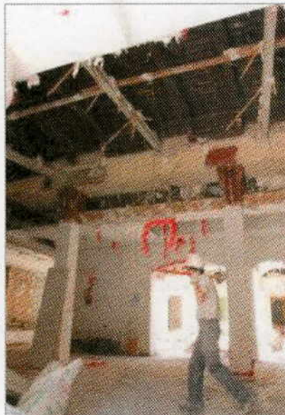
OCULTO. Los artesanados se encontraban tapados por falsos techos de escayola. / CARLOS MORET
